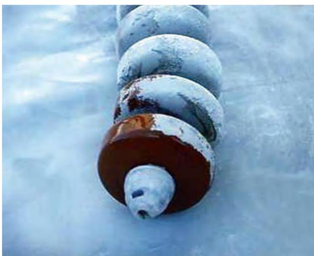
Figura 8 – Demonstração da limpeza com projecção de cortiça
