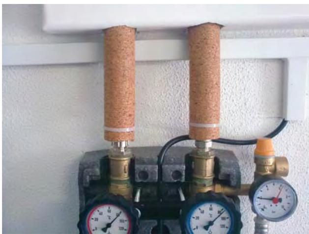
Figura 1 – Isolamento de tubagens com aglomerado de cortiça extrudido
