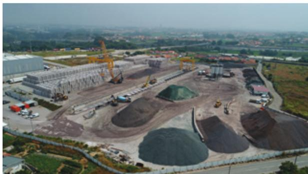
**Figura 2** Estaleiro de pré-fabricação dos blocos antifer para o prolongamento do quebra-mar exterior do Porto de Leixões
