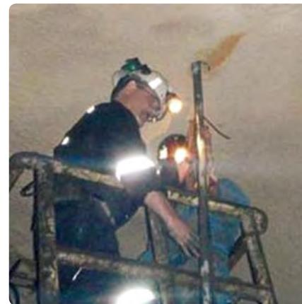
Figura 2 – Instalação da instrumentação no tecto da galeria
