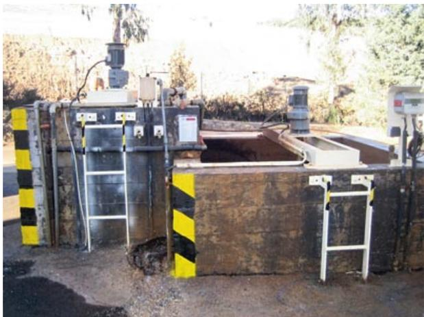
Figura 2 – Tanques de mistura, rápida e lenta, da ETALE
