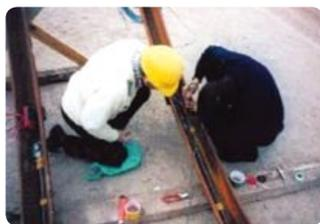
Aplicação do método no Túnel da Falagueira, com extensómetros instalados no interior das cambotas metálicas de suporte
