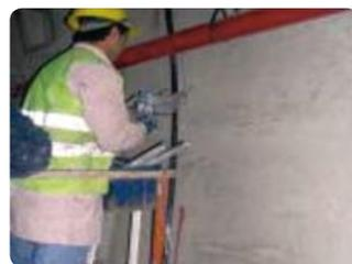
Fases da instalação de barras instrumentadas no Túnel do Rossio
