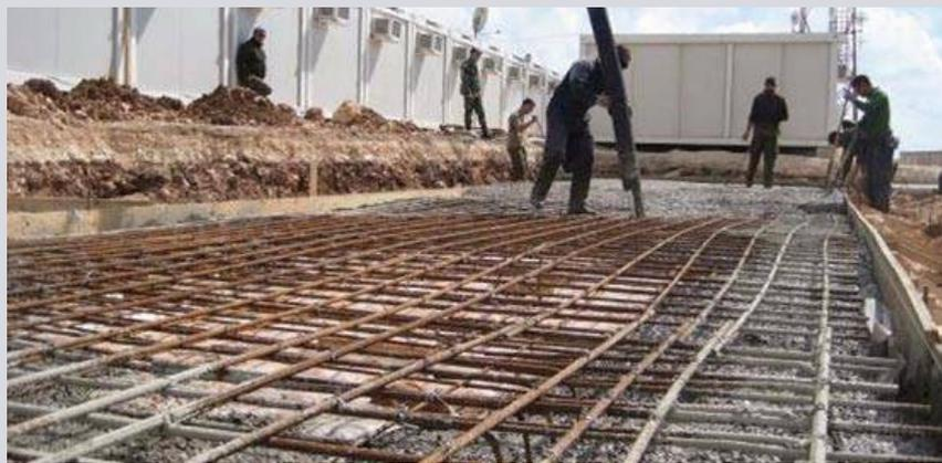
Fig. 5 – Betonagem da laje superior
