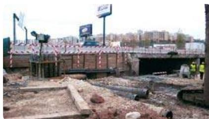
Novopca e Somague, a quem couberam as explicações técnicas. Foi possível visitar três frentes de obra, visualizando ensecadeiras de estacas-pranchas, entivações ancoradas do tipo “Berlim Provisório”, muros de gabiões e esta-
