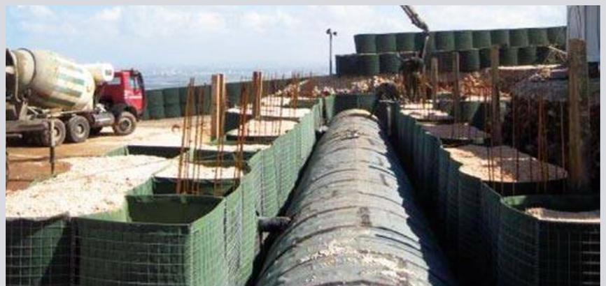
Fig. 4 – Shelters metálicas impermeabilizadas e protecção lateral com Hesco Bastions
