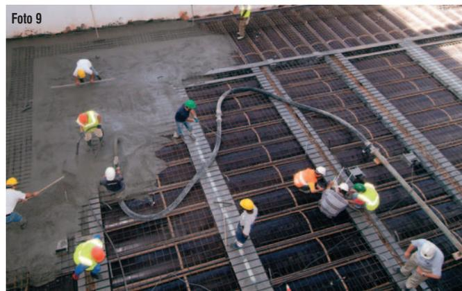
▶ Os elementos de betão armado foram, igualmente, objecto de reparação com argamassa textotrópica monocomponente. No caso particular da laje do piso 1 do edifício da baixa pressão, foi necessário, face aos sinais de profunda degradação, proceder à sua demolição e reconstrução, com recurso a soluções construtivas que mantivessem a “arquitectura” inicial. (Fotos 7, 8 e 9)
