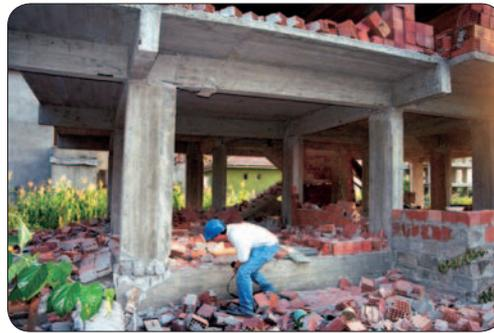
Figura 1 – Derrube e queda de paredes de alvenaria de enchimento devido ao efeito de um sismo
