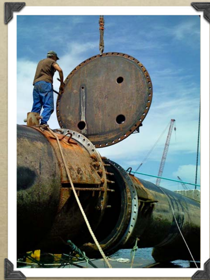
Retirada das flanges cegas
