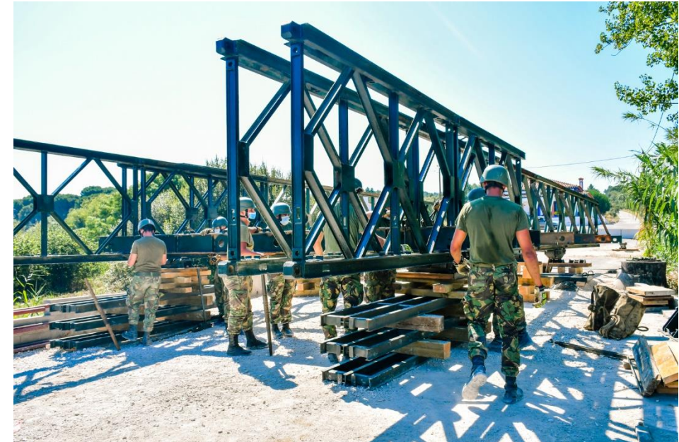
Instalação de Pontes
