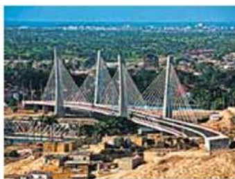
A ponte que valeu o Secil 2012
