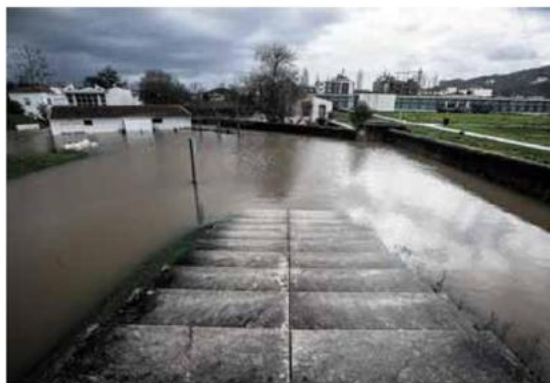
A água invadiu o mosteiro posto a descoberto no final dos anos 90 e destruiu equipamentos e documentos do centro de interpretação do monumento
