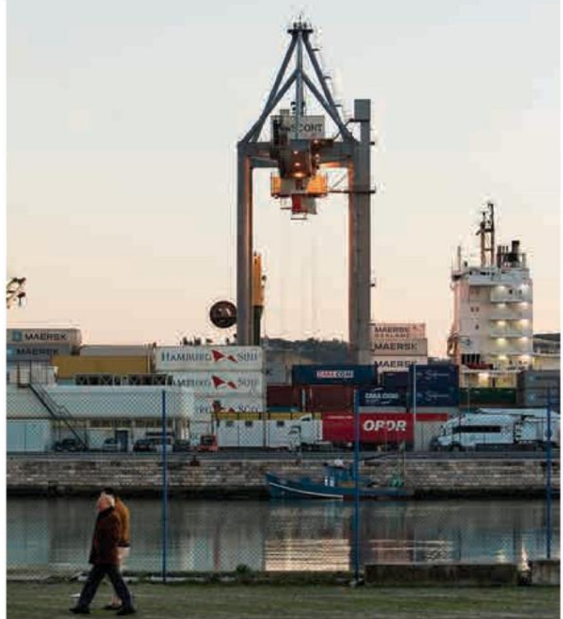
O porto de Lisboa tem sentido dificuldades em encontrar o local para um novo terminal de contentores.
