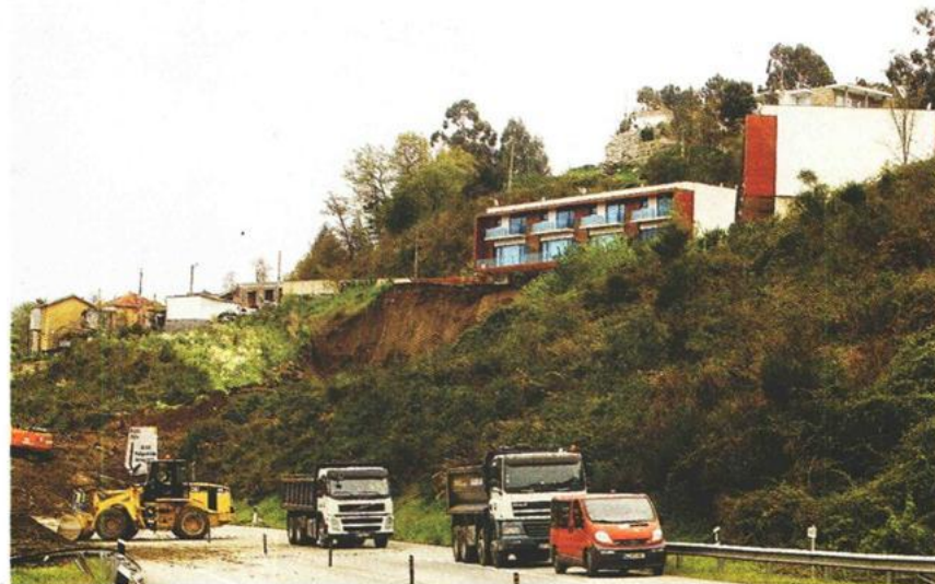
Terras que se abateram sobre Circular de Guimarães podiam encher 800 camiões
