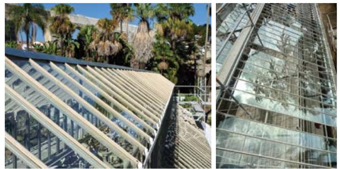
Figura 3 Pormenores da colocação dos vidros na cobertura da Estufa
