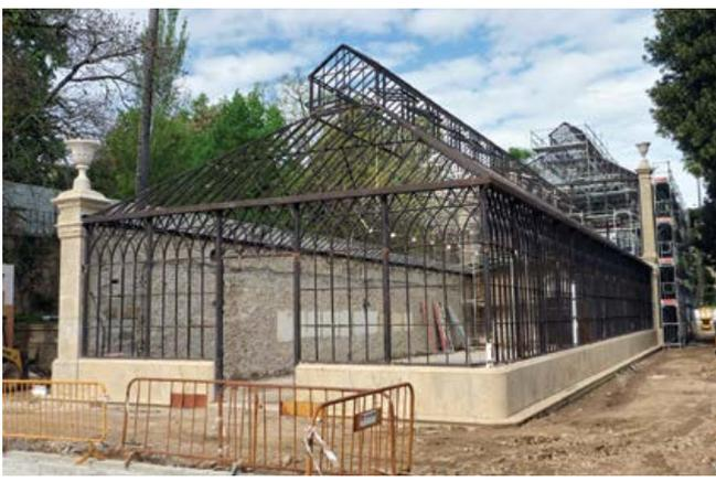
Figura 2 Reabilitação da estrutura da Estufa
