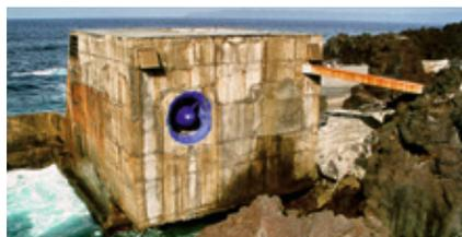
de costa, e forneceu pela primeira vez energia elétrica à rede da ilha em 1999. Foi, a nível mundial, a primeira central de energia das ondas projetada para ser integrada permanentemente numa rede elétrica, tendo operado até hoje alguns milhares de horas.
