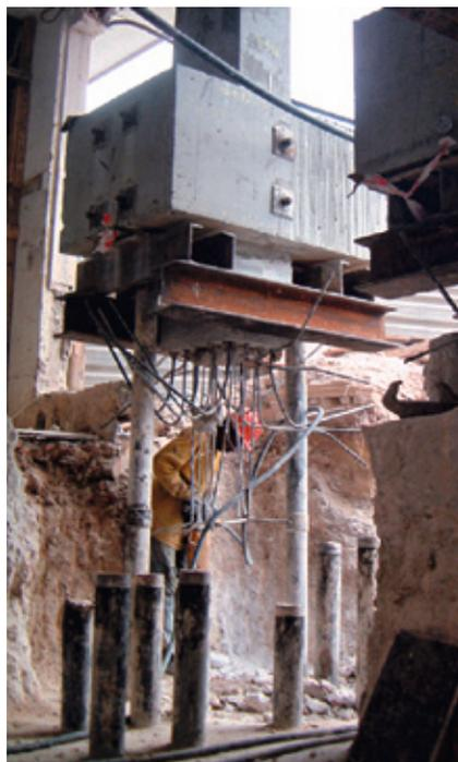
período, e até à solidarização com as microestacas, a sapata poderá perder alguma da sua resistência estrutural. Genericamente, a metodologia de reforço associada ao uso destas soluções passa pela execução das microestacas o mais próximo possível da fundação existente,
