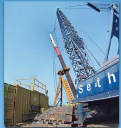
Sobre as estacas foram colocados vários elementos prefabricados de betão (vigas até 30 toneladas e lajes pré-esforçadas), sendo o resto da estrutura betonada *in-situ*.
