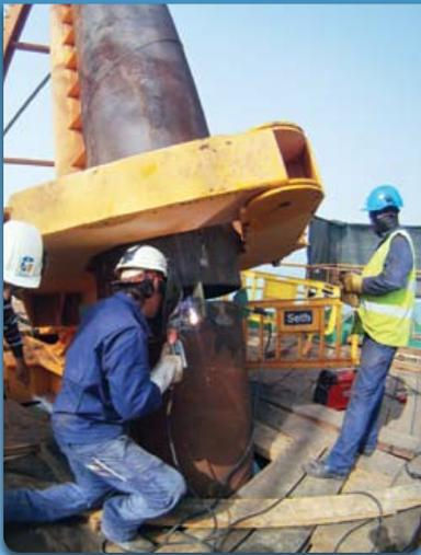
equipamento flutuante, tradicional neste tipo de empreitadas, tendo-se optado pela criação de uma estrutura metálica, batizada de “Traveller” que avança sobre as estacas tubulares metálicas, que vão sendo sucessivamente cravadas para a própria construção do cais. Trata-se de uma solução
