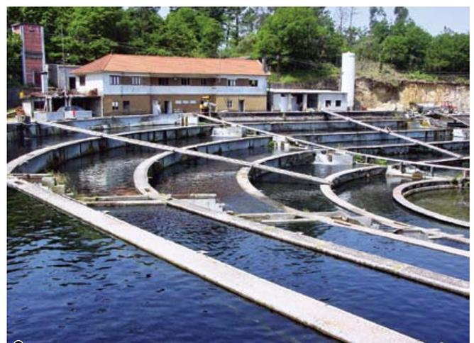
Figura 4 – Tanques de betão dispostos em escada, usados na produção de trutas (Truticultura do Minho – Paredes de Coura)
