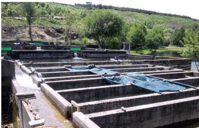
Figura 5 – Tanques com forma retangular, onde é possível verificar a água a passar entre estes por gravidade (Trutalcôa – Sabugal)
