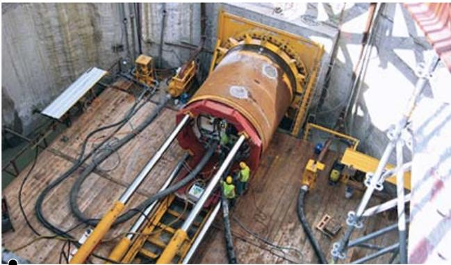
Figura 8 – Tuneladora a efetuar a perfuração dos emissários
