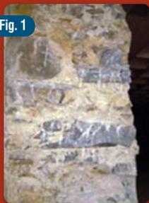
Pela necessidade de aplicação dos novos regulamentos sísmicos, agravada pela inclusão de alterações arquitectónicas, foi, em parceria com o IST, entidade contratada pelo Dono de Obra, feita a definição e caracterização de uma solução de reforço estrutural para as paredes de alvenaria de pedra do edifício existente, com cerca de 90 cm de espessura (fig. 1).
