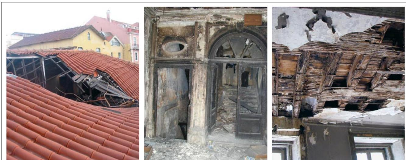
Figura 2 – Degradação da cobertura em telhado (Esq.) e da estrutura existente por acção do fogo (Centro) e da água (Dta.)
