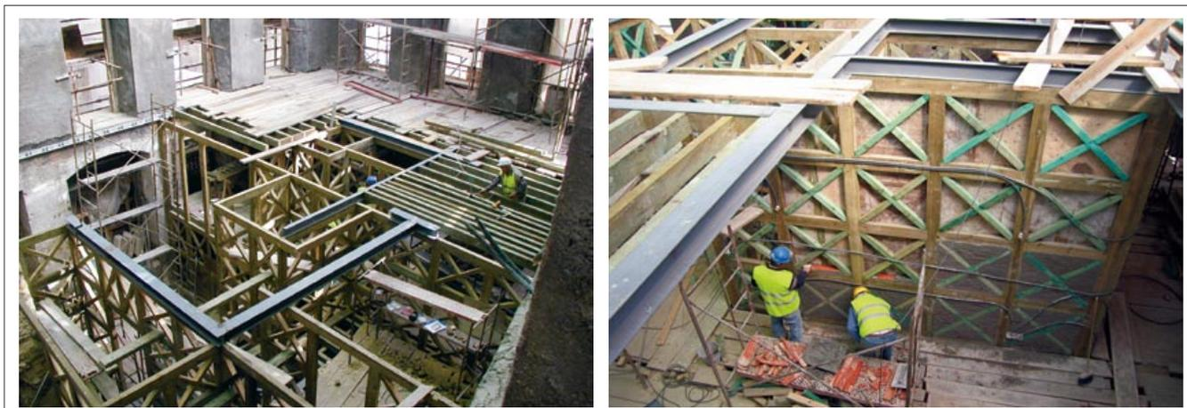
Figura 3 – Estrutura interior nova (Esq.); Preenchimento das paredes de frontal (Dta.)
