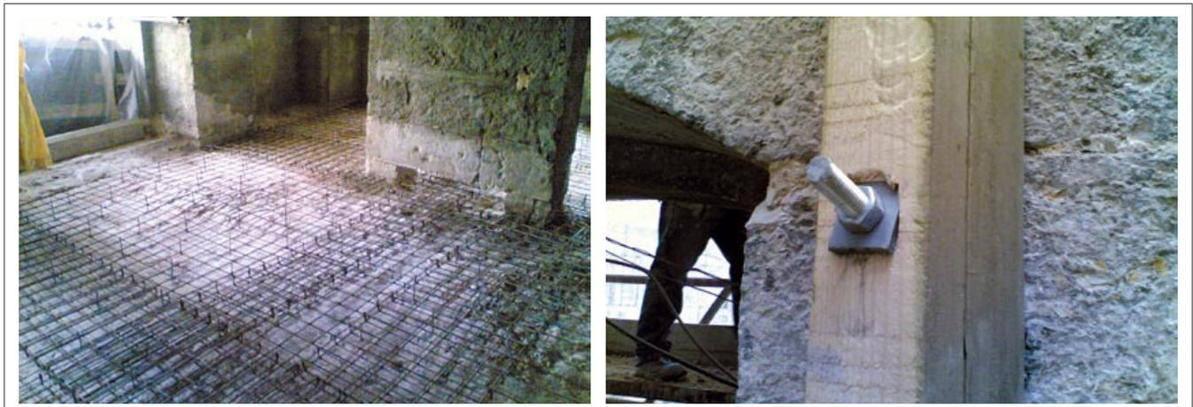
Figura 4 – Reforço de abóbadas (Esq.); Pregagem de um frontal à fachada (Dta.)
