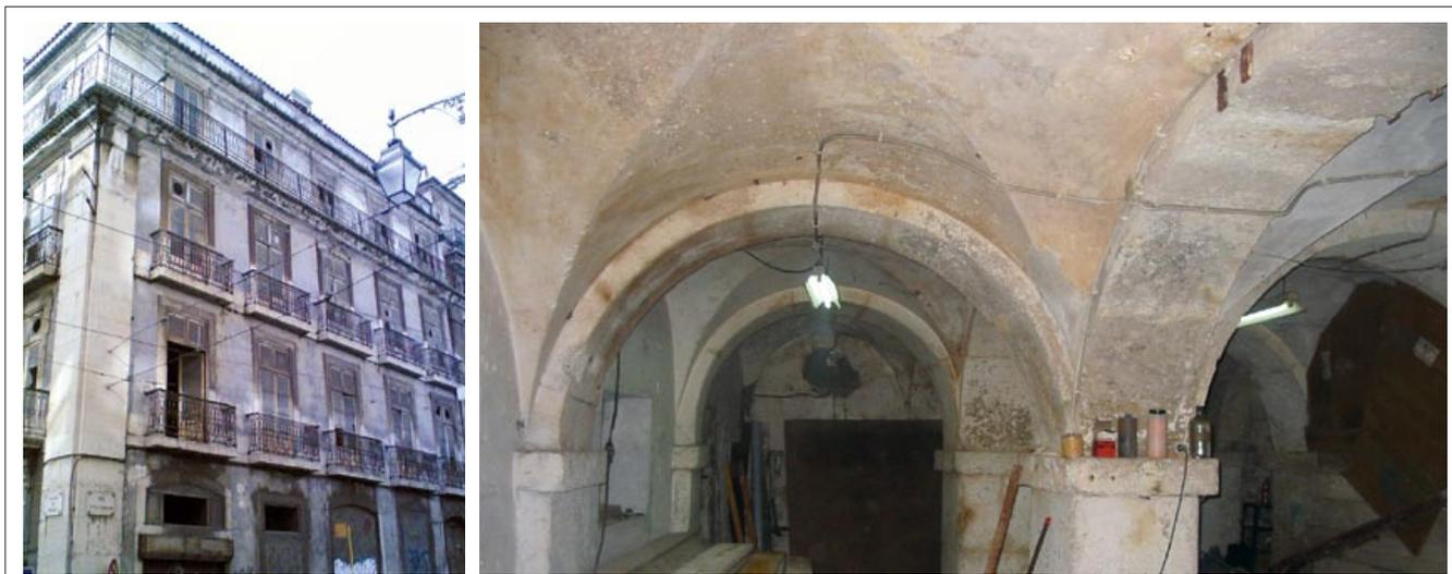
Figura 1 – Fachada principal (Esq.); Arcos e abóbadas de alvenaria de pedra (Dta.)
