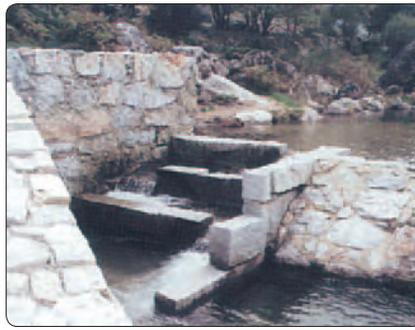
Zêzere. O açude dispõe de uma pequena escada de peixes, por onde flui o caudal ecológico e de dispositivo tubular que permite garantir o caudal necessário às levadas a jusante e à truticultura.
