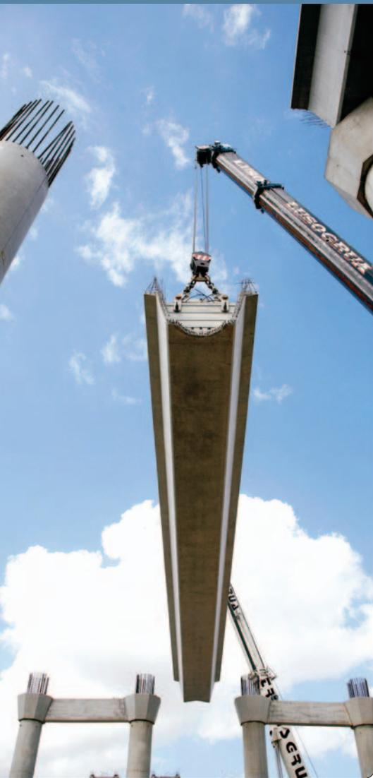
Fig. 6 – Pormenor da colocação de vigas pré-fabricadas no Viaduto Sul
