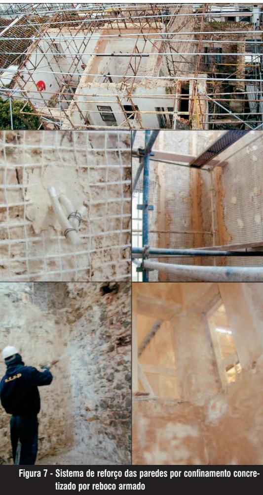
Figura 7 - Sistema de reforço das paredes por confinamento concretizado por reboco armado
