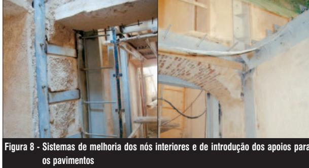
Figura 8 - Sistemas de melhoria dos nós interiores e de introdução dos apoios para os pavimentos
