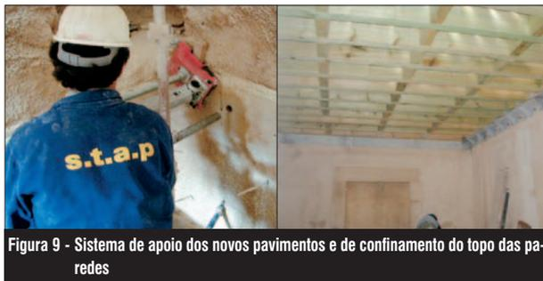
Figura 9 - Sistema de apoio dos novos pavimentos e de confinamento do topo das paredes
