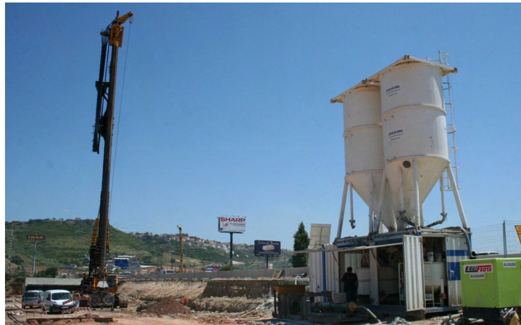
Fotografia da frente de obra durante a execução dos trabalhos
