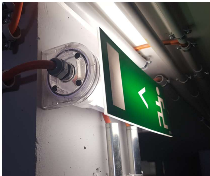
Placa colocada sobre a luminária de 1 face
