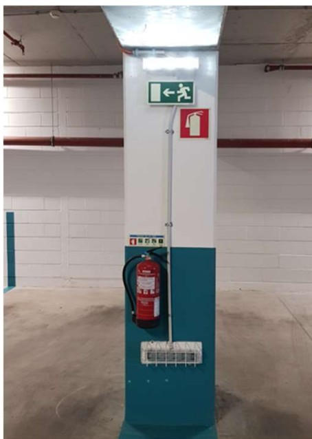
Considerado “má prática”. Emissão da luz para a frente, provoca encandeamento e não ilumina o pictograma nem o meio de intervenção e combate ao incêndio.
