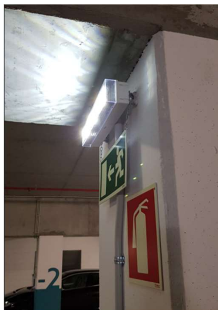
Considerado “má prática”. Emissão da luz para a frente, provoca encandeamento e não ilumina o pictograma nem o meio de intervenção e combate ao incêndio.
