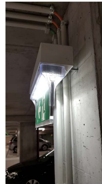
Emissão de luz para baixo, ilumina o solo e o pictograma e, se existisse, iluminaria o meio de intervenção e combate ao incêndio.
