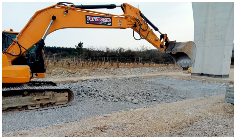
Tratamento da plataforma de apoio do cimbra ao solo
