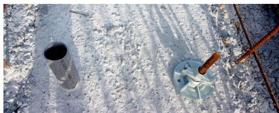
Figura 13 – Tubos PVC para fixação das barras de dywidag (a vermelho) e abaixamento de cofragem (a azul)
