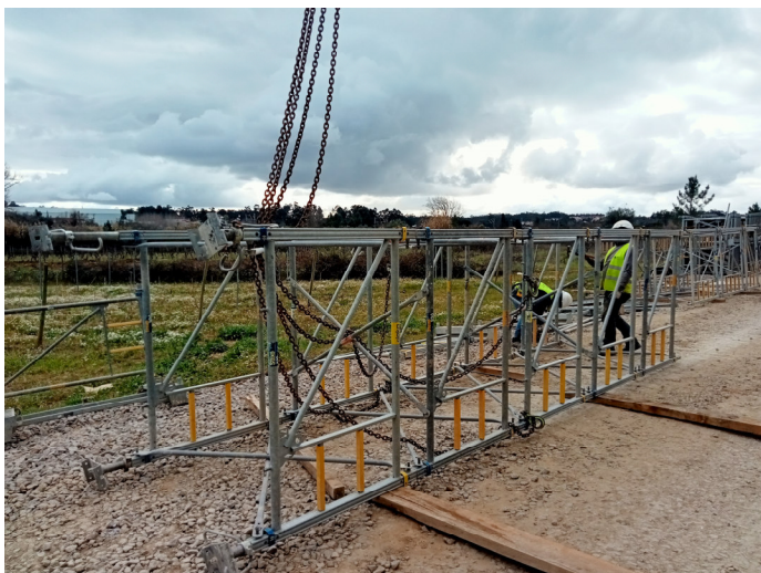
Torres de cimbra
