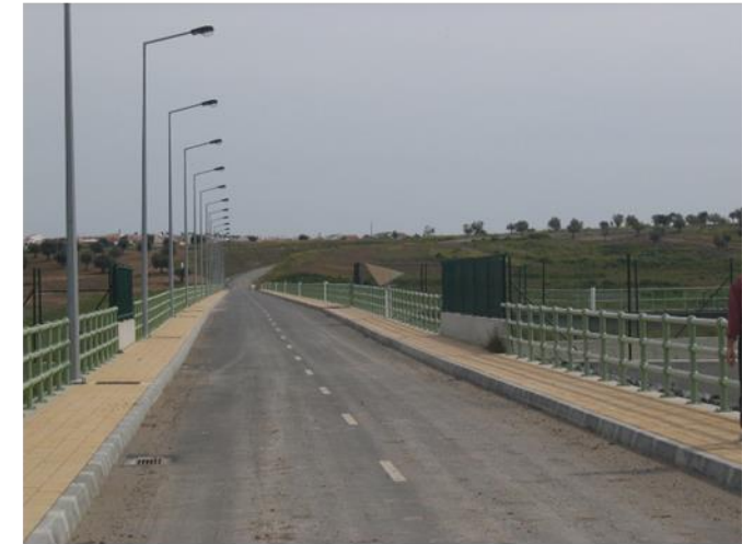
Barragem do Pizão
