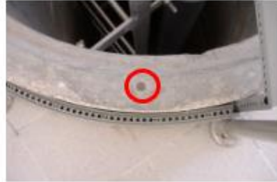
R0 - Marca de contacto do poço do Marégrafo Acústico
