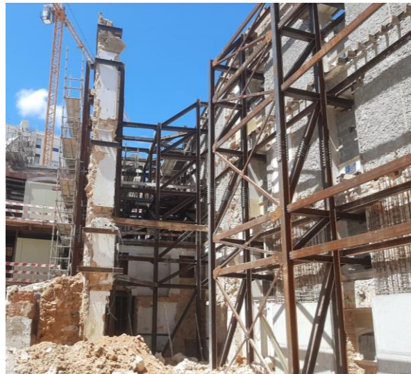
Fachadas 2 e 3 – Julho de 2021
