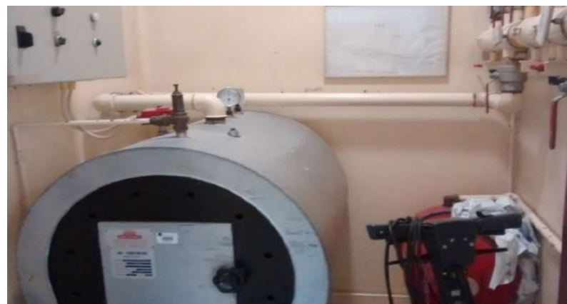
Foto 10 – Zona Técnica interior
