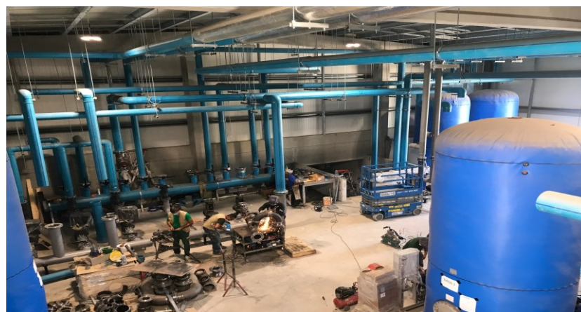
Foto 21 – Central Térmica Vista: Execução trabalhos Local: HSM
