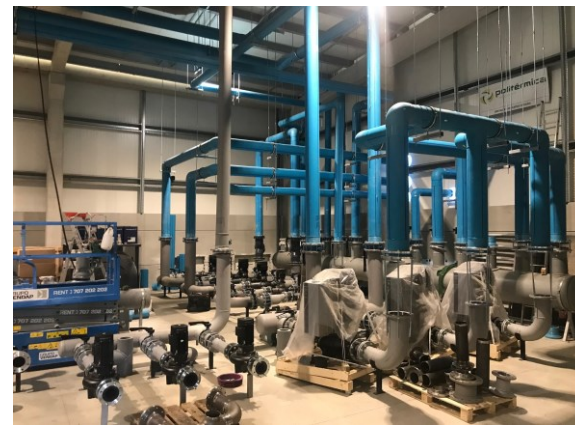
Foto 19 – Central Térmica Vista: Execução trabalhos Local: HSM
