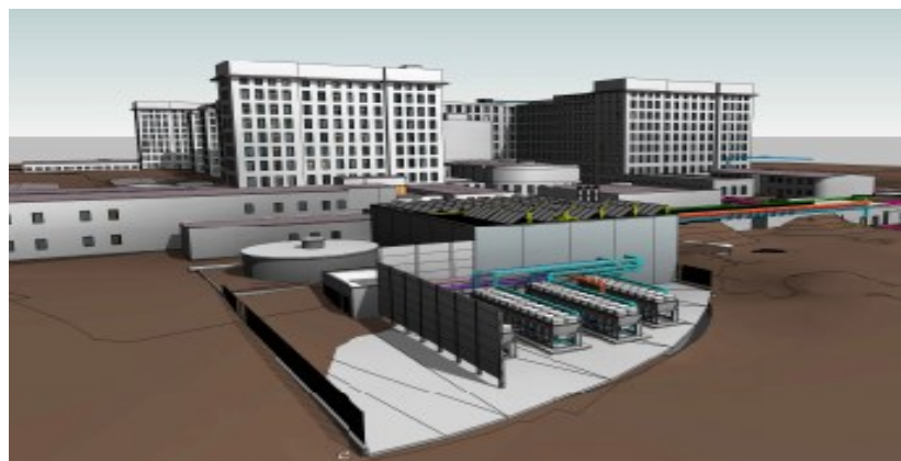
Imagem 2 – Edifício Central Térmica
