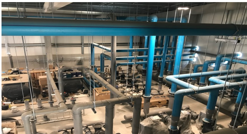
Foto 20 – Central Térmica Vista: Execução trabalhos Local: HSM
