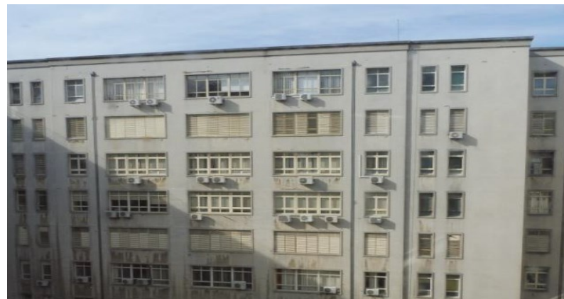
Foto 12 – Fachada com unidades exteriores
