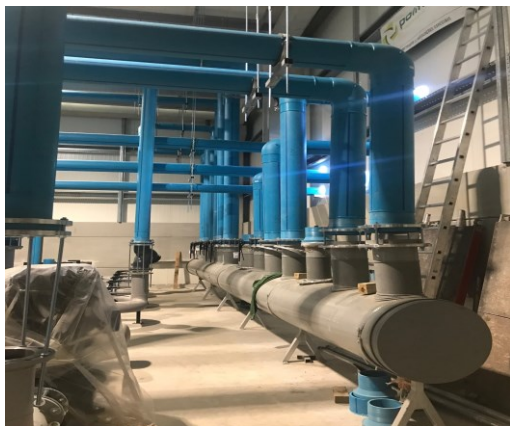
Foto 17 – Central Térmica Vista: Execução trabalhos Local: HSM
