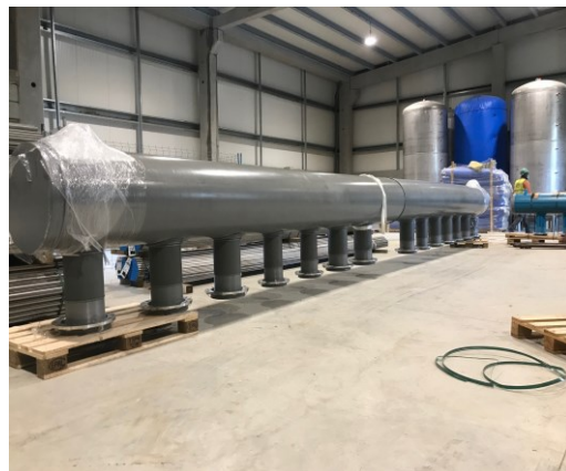
Foto 18 – Central Térmica Vista: Execução trabalhos Local: HSM
