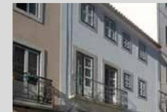
Rua das Trinas 11
