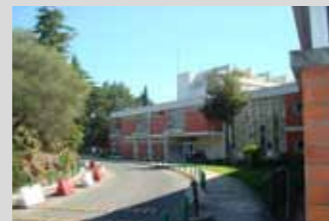
Escola Superior de Alcoitão Refeitório e da biblioteca
