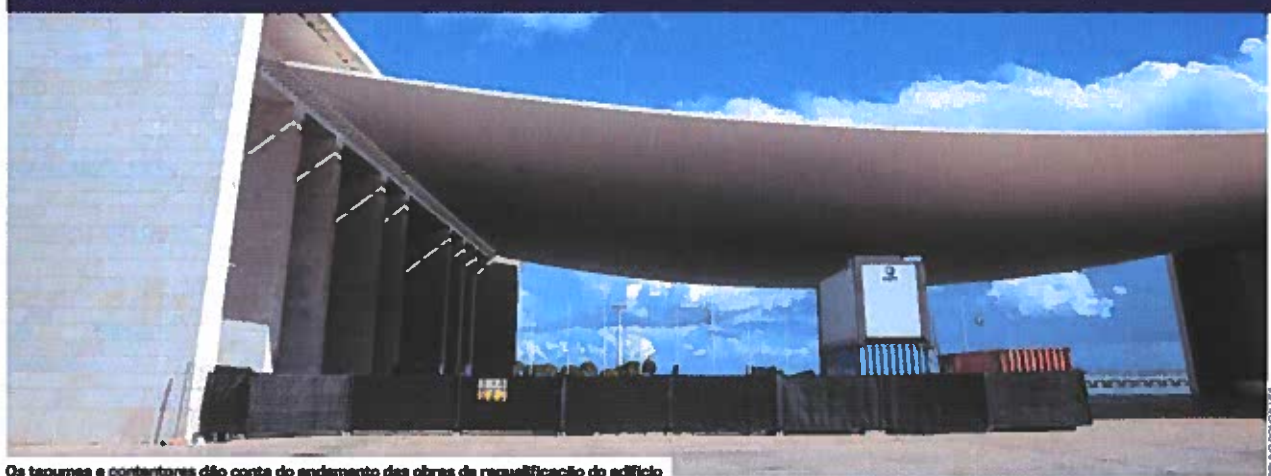
Os tapumes e contentores dão conta do andamento das obras de requalificação do edifício
