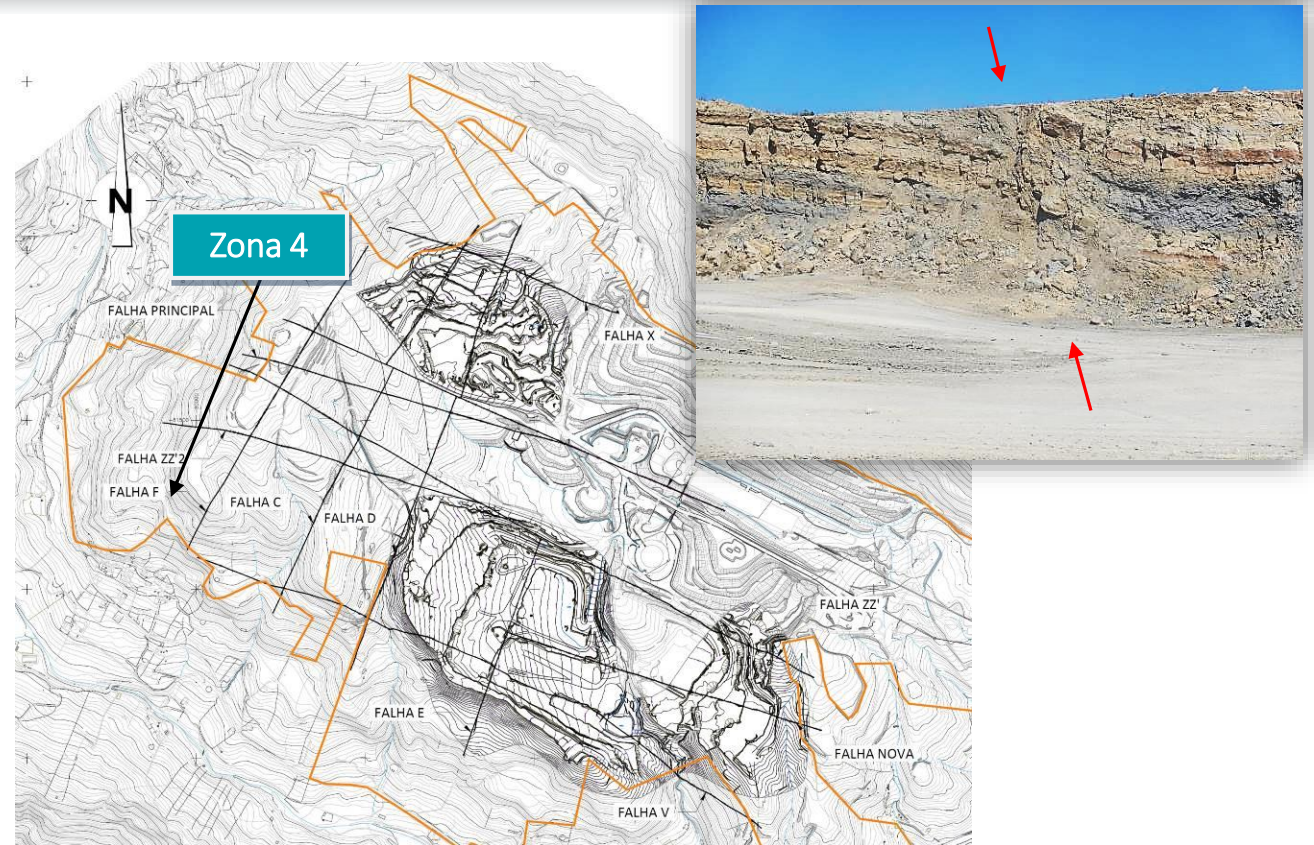
Falhas geológicas identificadas na área da pedreira.
