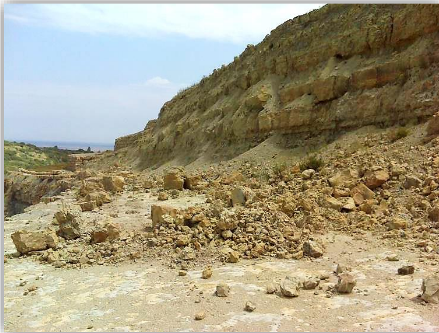
Erosão diferencial observada na antiga frente de escavação, com acumulação de materiais caídos
