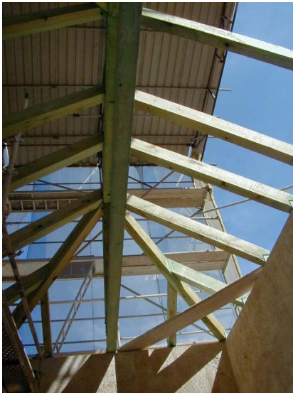
Cobertura - construção metálica e madeira, leve.
