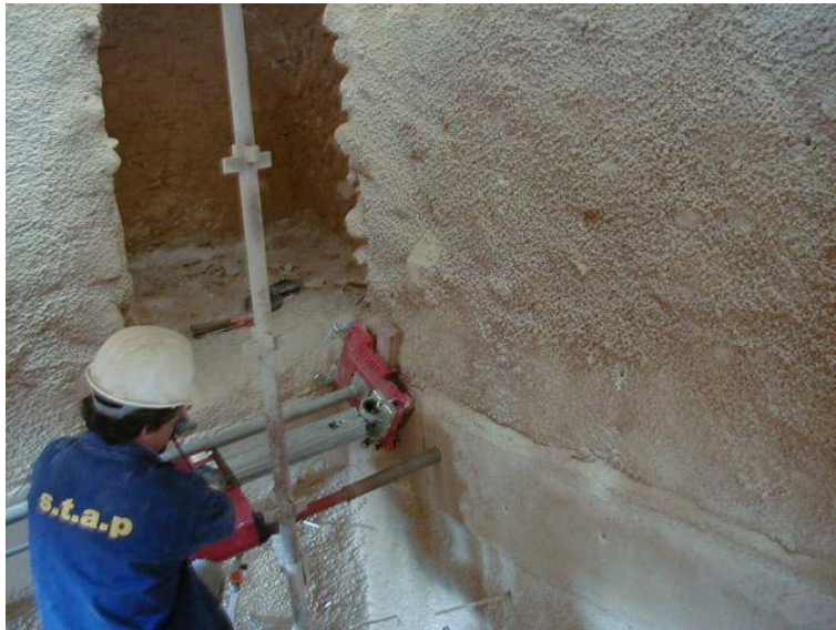
Métodos de furação com introdução mínima de vibração e sem água.
