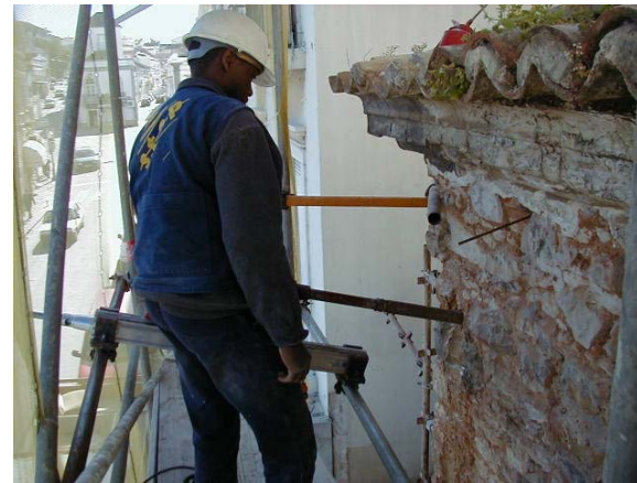
Furação dos cunhais.
