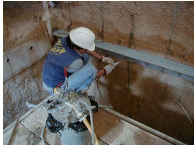
Injecção de selagem dos varões passantes de ancoragem do reforço.
