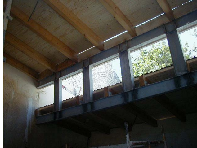
Cobertura - construção metálica e madeira, leve.
