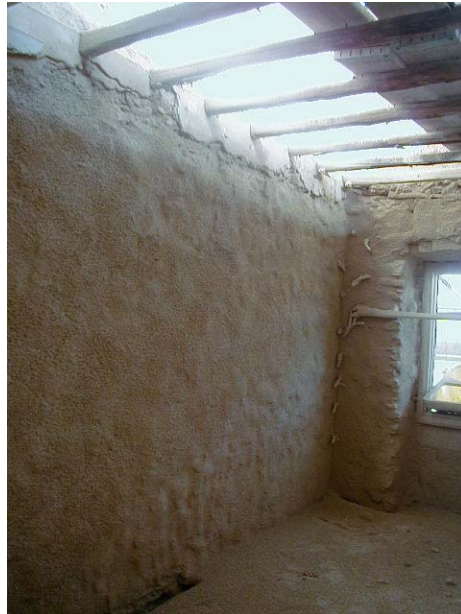
Consolidação dos cunhais através de pregagens de manga injetada.
