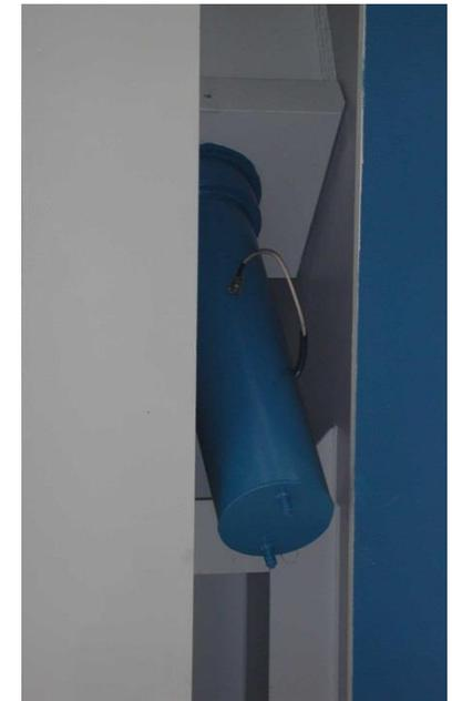
Ancoragem no tabuleiro. Um dos cordões tem instalado uma célula de carga para monitorização do tirante.
