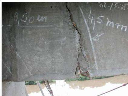
Vista dos cabos de reforço deteriorados
