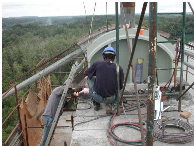
Montagem selas provisórias para passagem dos cabos sobre o pilar
