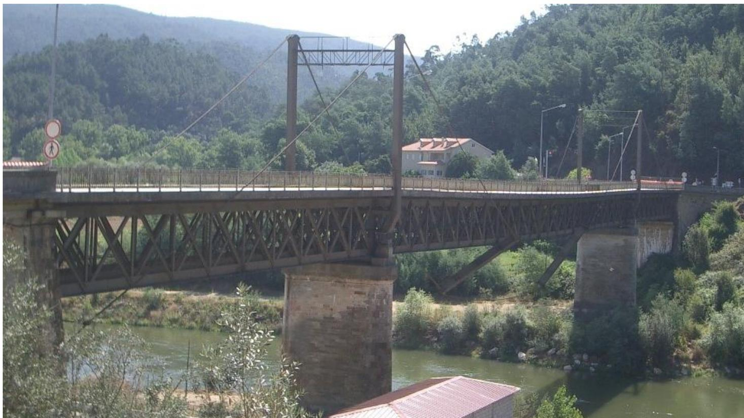
A rotura dum tirante colocou em risco a segurança do tabuleiro.
