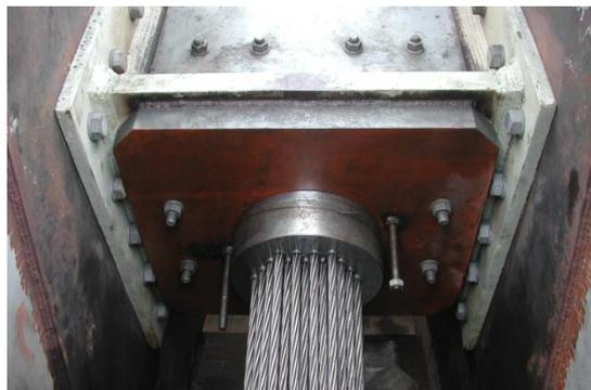
Cabos provisórios da ancoragem do tabuleiro
