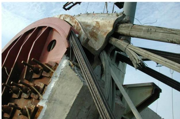
Montagem das ancoragens provisórias e remoção das existentes
