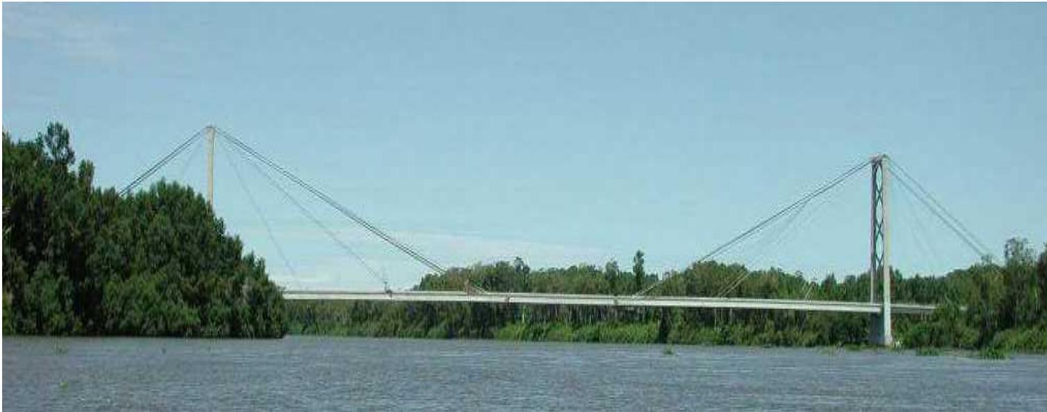
Ponte com 400 metros de comprimento, tabuleiro misto aço-betão, com dois vãos extremos de 70m e um central de 260m.
