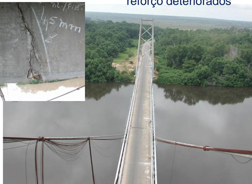
A reabilitação consistiu na substituição integral do sistema de tirantes, complementada com o reforço dos coroamentos das torres e na reparação e pinturas gerais da estrutura metálica e da de betão.
