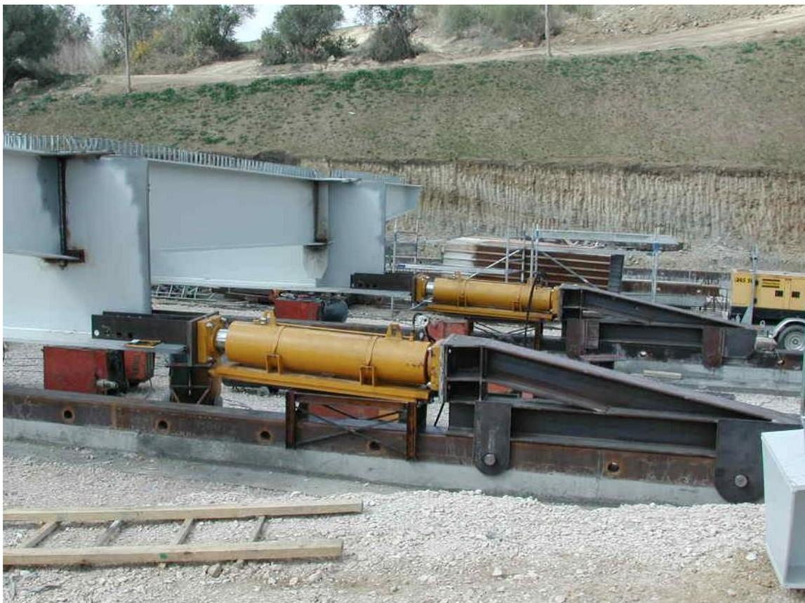
Cilindros hidráulicos de empurre
