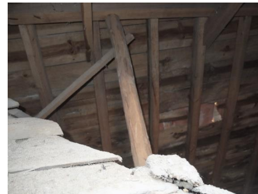
Reforço/configuração de estrutura inadequados
