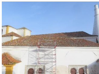
Cobertura da Capela
