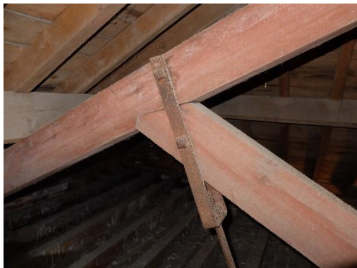
Corrosão dos elementos metálicos de ligação
