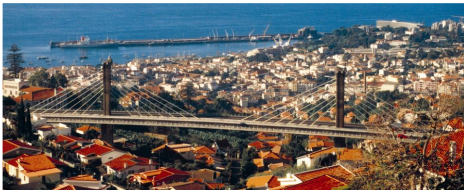
Viaduto atirantado "Cota 200", Funchal
