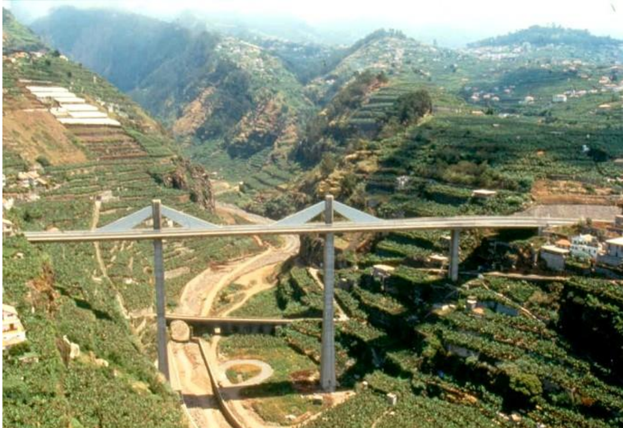
Fase Construtiva - Ponte de tirantes Fase Final - Tirantes numa lamina de betão –“VELAS”
