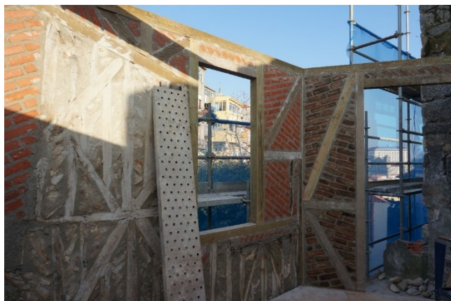
Rua das Taipas – Consolidação de paredes mistas (taipa rodízio)
