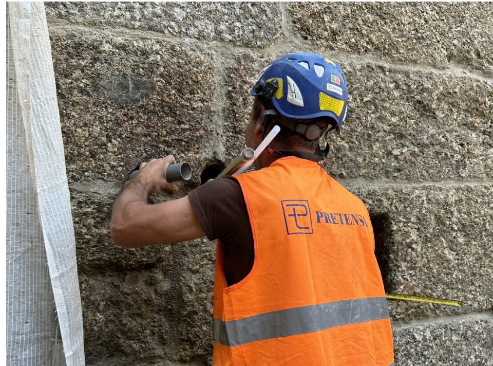
Desobstrução das furações para montagem das pregagens
