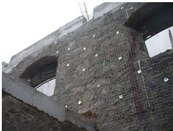
Arquipélago Açores – Reforço sísmico: reboco armado com argamassas à base de cal e malhas poliméricas. Pregagens de ligação entre panos de alvenaria.
