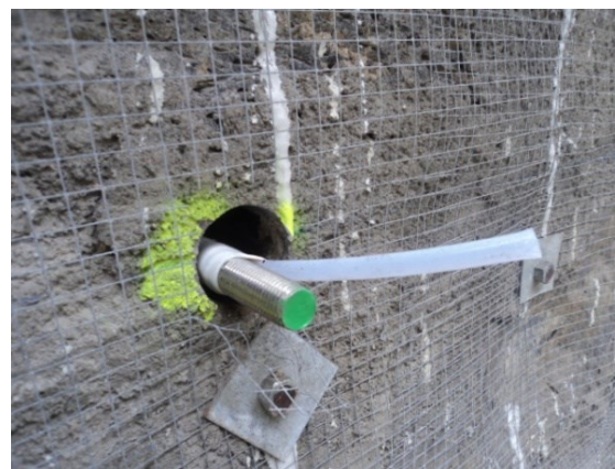
Arquipélago Açores – Reforço sísmico: reboco armado com argamassas à base de cal e malhas poliméricas. Pregagens de ligação entre panos de alvenaria.
