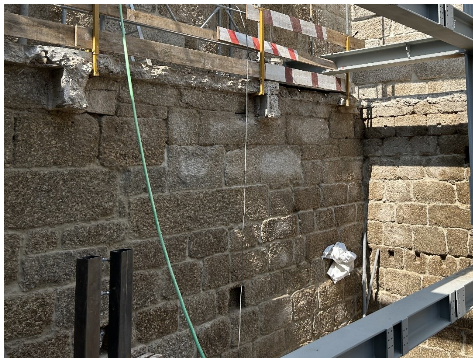
Tratamento de juntas em alvenaria com argamassa à base de cal hidráulica natural
