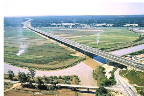
Fig. 9: Ponte do Sado – Portugal (1997)
