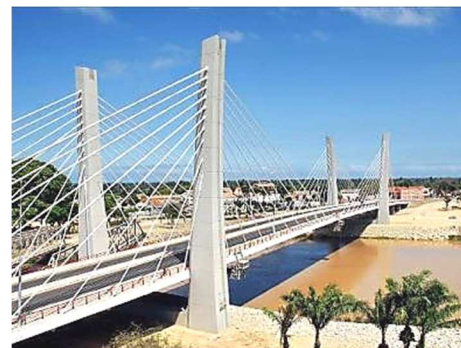
Fig. 15: Ponte 4 de Abril – Angola (2009)
