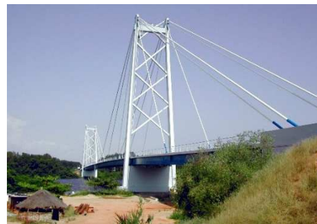
Fig. 18: Ponte da Barra do Kwanza após a reabilitação – Angola (2003)
