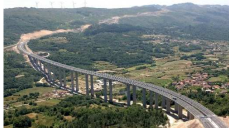
Fig. 12: Viaduto de Vila Pouca de Aguiar – Portugal (2007)
