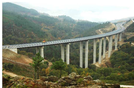
Fig. 16: Viaduto VIX – Portugal (2005)
