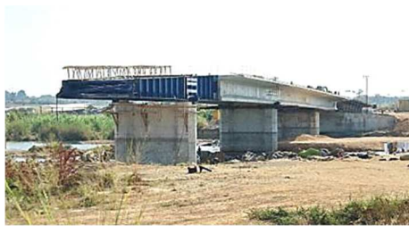
Fig. 6: Lançamento do tabuleiro da Ponte do Cubal da Hanha – Angola (2009)
