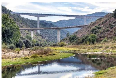
Fig. 7: 1º plano: Antiga Ponte do Tua (1985); 2º plano: Nova Ponte do Tua (2012). Portugal
