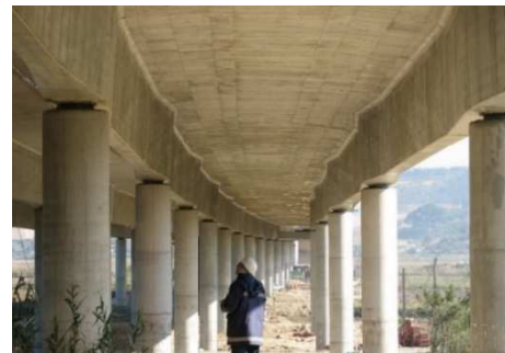
Fig. 5: Armando Rito debaixo do Viaduto do Rio Pranto – Portugal (2008)
