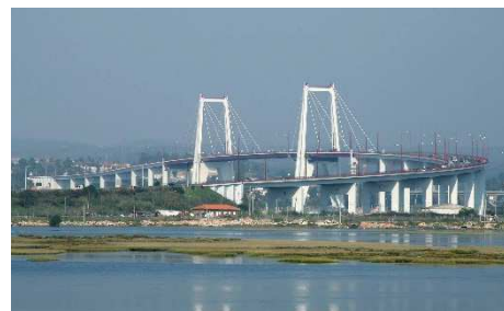
Fig. 19: Ponte Edgar Cardoso após a reabilitação – Portugal (2005)
