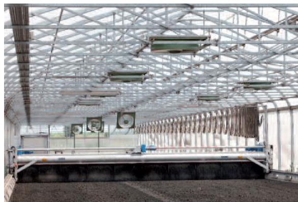
Dispositivo revolvente de lamas em funcionamento na estufa
