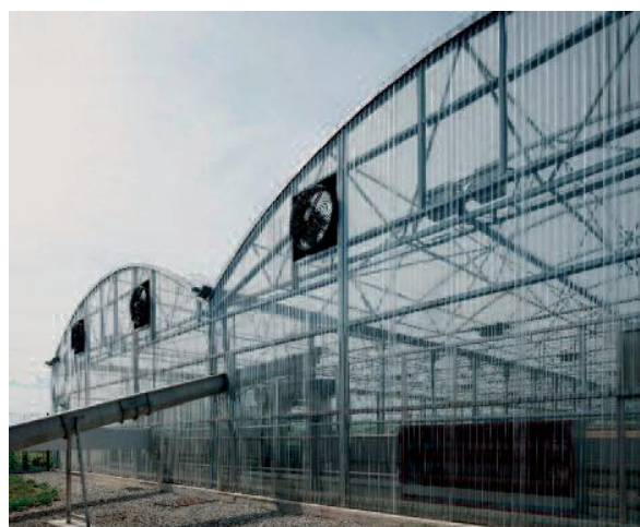
Alimentação de lamas automatizada com sem-fim
