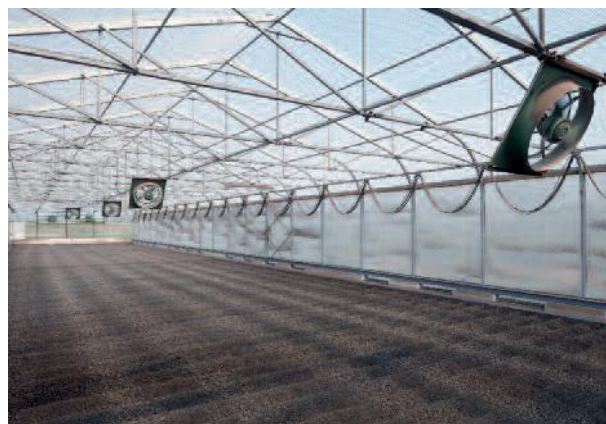
Os ventiladores "fornecem" ar seco sobre o leito de lamas
